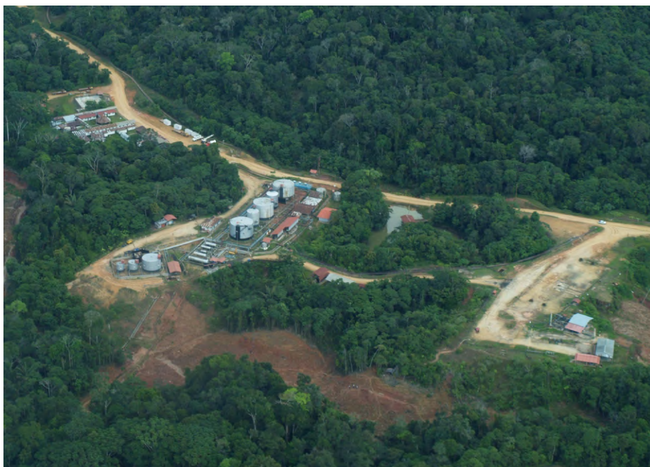
▲ Vista aérea de instalaciones petroleras
